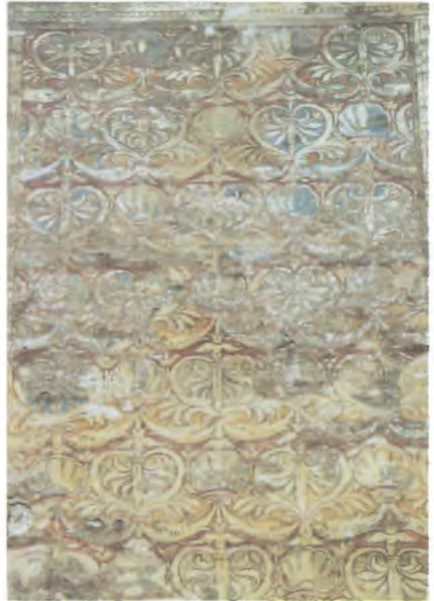
Vicenza, palazzo Monza Regaù, facciata su contra' xx Settembre (fotografia di Andrea Lomazzi) e particolare dell'affresco ad "arazzo" (fotografia di David Tomasi e Mirko Fedrigo)
