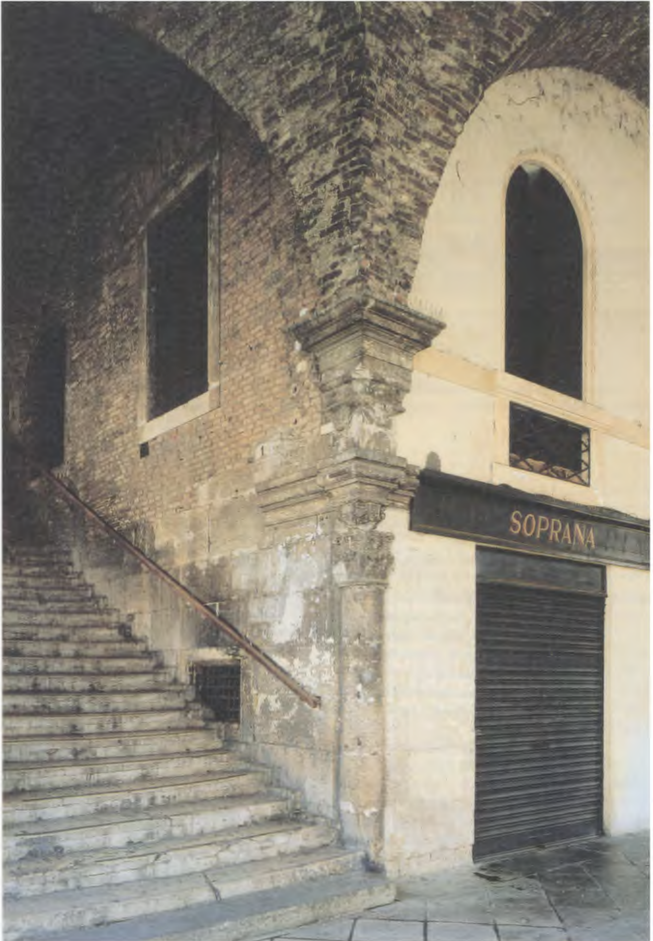
In corrispondenza dell'angolo nord-ovest della Basilica sono ancora oggi riconoscibili, sovrapposti, i capitelli del Palazzo di Domenico da Venezia (1444-1459), Tommaso Formenton (1481-1494) e Andrea Palladio (1549-1550). (Fotografia dello Studio fotografico Nerosubianco, Vicenza)
